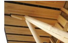
柱のない大空間をつくるために採用した150×450ミリの集成材の大梁。スリットからその大きさを覗かせながらも、主張しすぎないようにしています。
