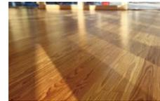
フローリングは岐阜県産スギ材を圧密加工したもので、30ミリのスギ板を15ミリまで圧縮。傷つきにくく、優しい風合い。
