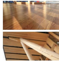
上：フローリングは岐阜県産スギ材を圧密加工したもので、30ミリのスギ板を15ミリまで圧縮。傷つきにくく、優しい風合い。
